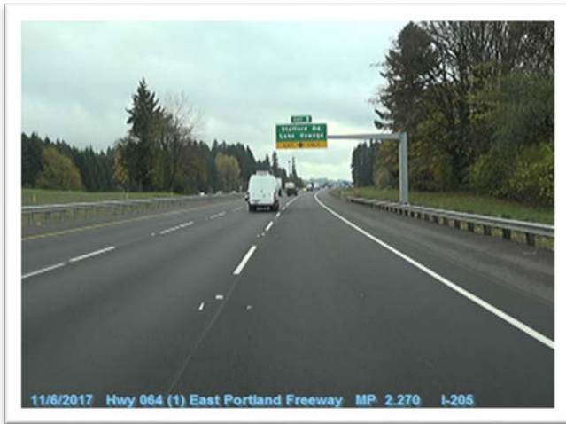
IM Paving I-205 Portland Area
